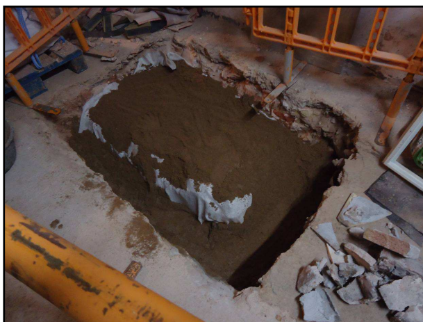
Imatge 4: Detall del procés de rebliment indefinit de la cala. Foto: CODEX
